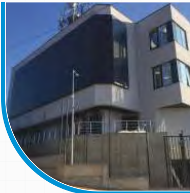
TURKCELL DATA CENTER Edirne
